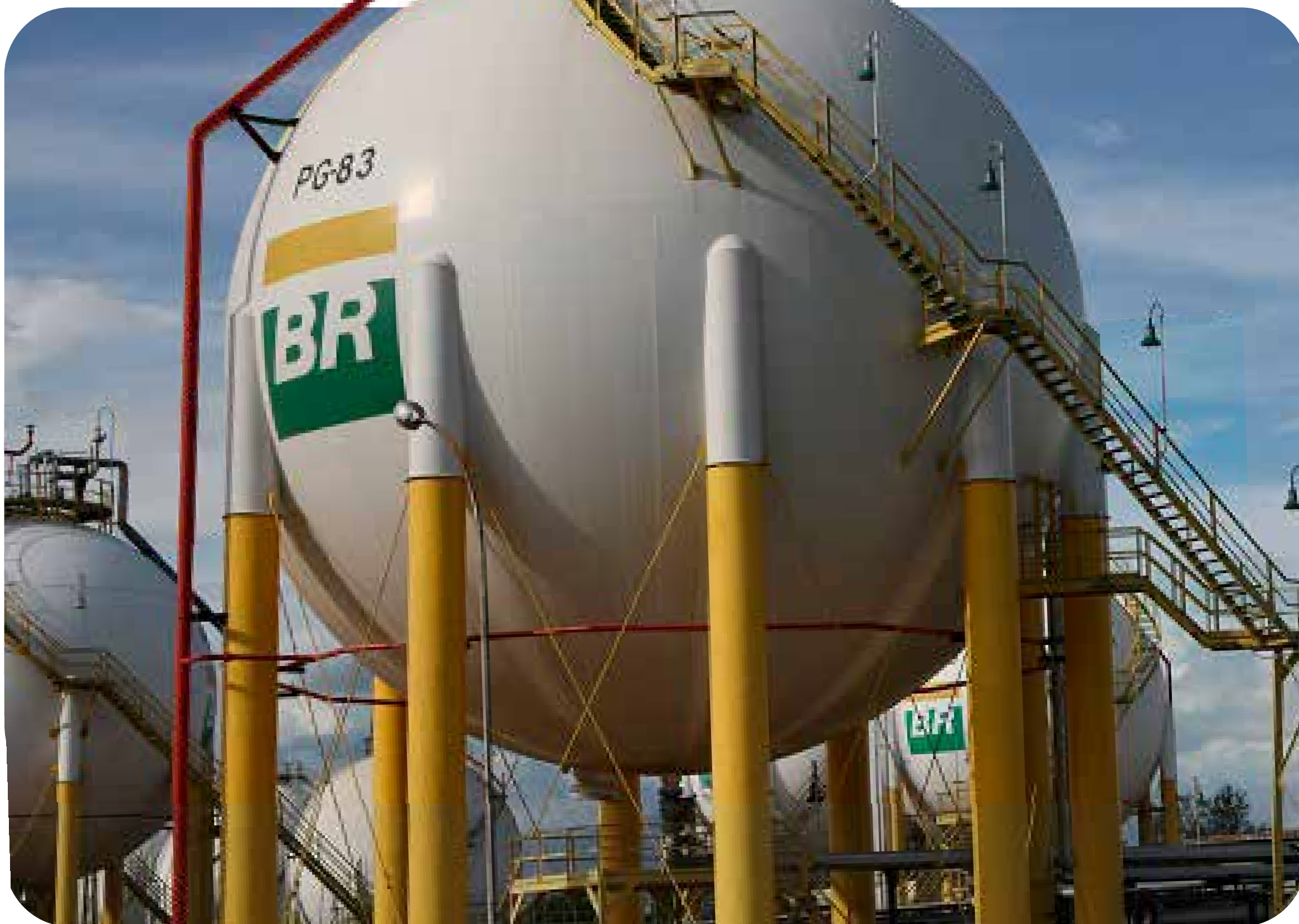
Esfera de armazenamento de gás liquefeito de petróleo (GLP). Foto: André Motta de Souza / Agência Petrobras
